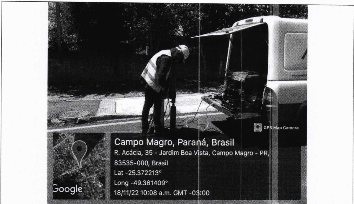
Extração de corpo de prova na rua Acácia – Jardim Boa Vista – Campo Magro
